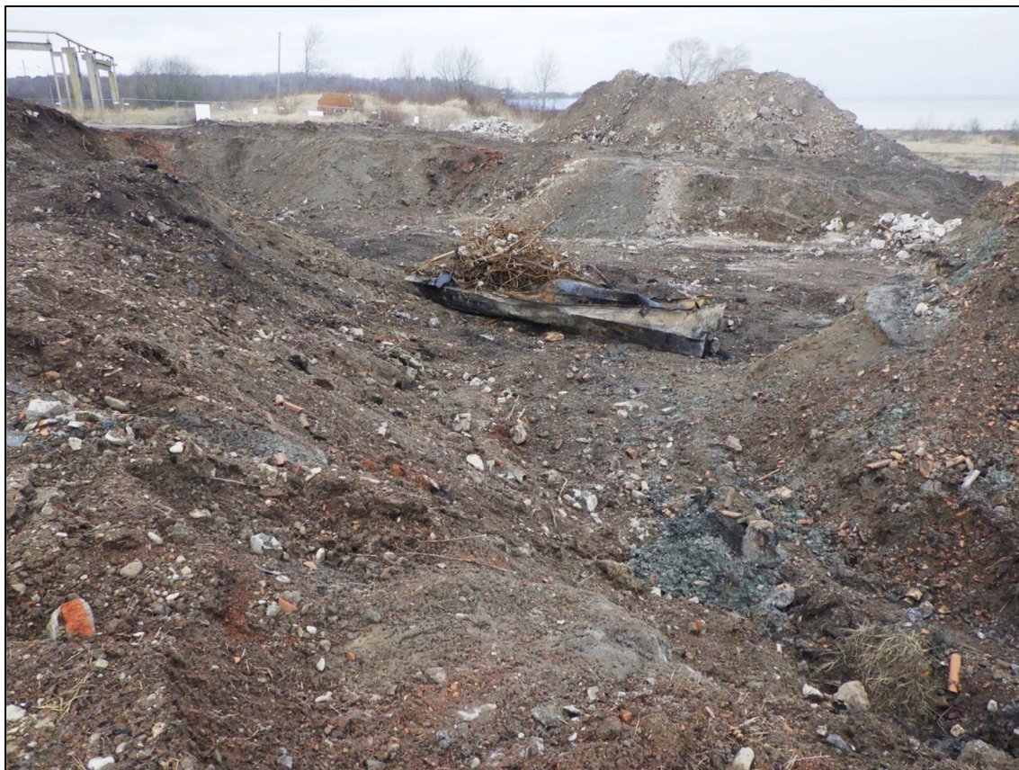
Foto 8. Aseri endise keskkatlamaja maa-aluse masuudihoidla likvideerimine. Mahutid on tühjendatud ja likvideeritud, ees ootab reostunud pinnase eemaldamine (17.01.2020).
